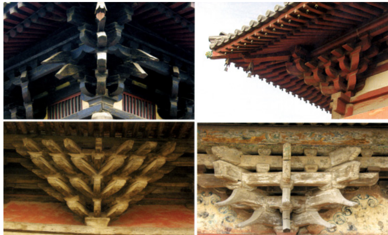
古代宫室顶部的檐角结构
